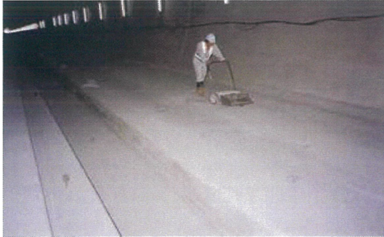
①コンクリート面の清掃
