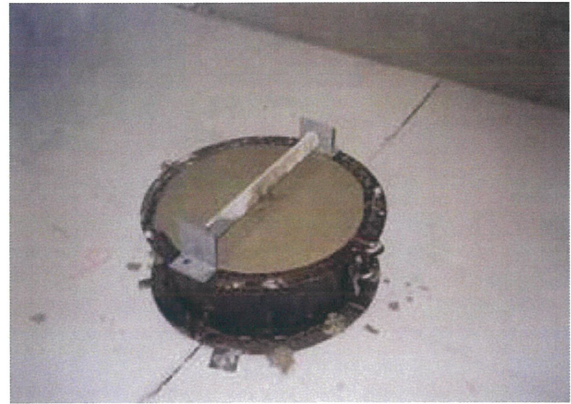
⑲突起コンクリート打設
