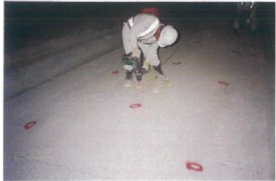
②アンカー筋のマーキング削孔
