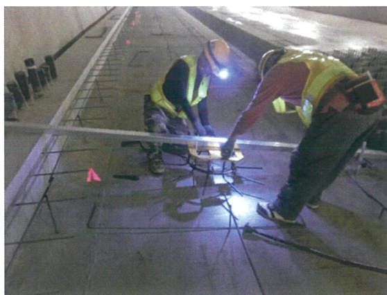
④突起コンクリート下部鉄筋設置
