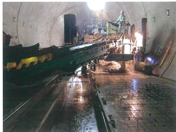
⑪コンクリート打設
