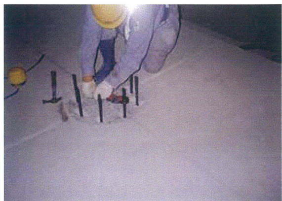
⑰突起コンクリート上部鉄筋組立
