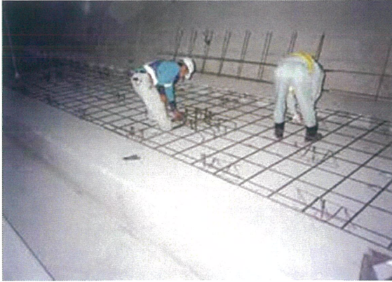
⑥鉄筋（メッシュ筋）の組立設置
