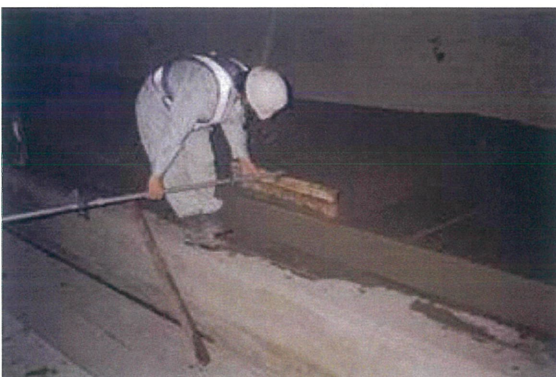
⑯コンクリート打設状況
