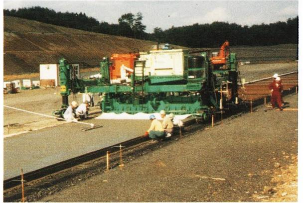
設し、鉄筋を設置してから上部のコンクリートを舗設する手順が一般的であるが、今回の施工では、あらかじめ配筋を終えてからワンパスで打設・成型を行う方式が可能であり、1 日当たりの施工量も平均 176m（最大 255m）となり、SF 工法のメリットも十分に発揮できたものと考えられる。
