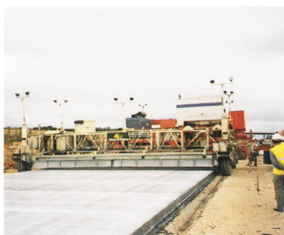
SF工法により施工中のコンクリート舗装（左写真）と防護柵
