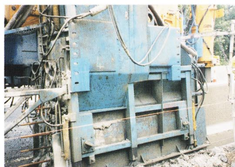
SF工法により施工中のコンクリート舗装（左写真）と防護柵
