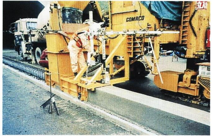
m間隔で塩ビ管を鉄線により固定した。使用したコンクリートは、粗骨材最大寸法20mm、単位セメント量310kg/m<sup>3</sup>、水セメント比46.0%、細骨材率39.9%で、施工位置での目標スランプを4cmとした。これにより当初計画どおりの期間で施工を終えることができ、良好な仕上がり性状が得られた。（大成ロテック(株) 中丸貢）
