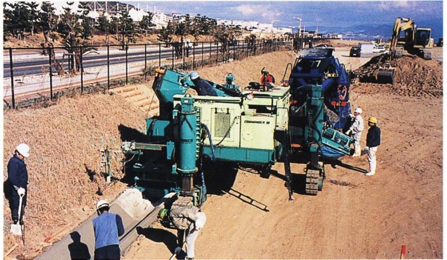
施工するに当たり当初懸念していた2断面の設計から、流量のとれる大きい断面の1タイプに変更(設計変更でなく施工承諾)された。そのことにより1タイプのモールドの製作で済み、モールドの取り替え等のコスト及び手間も抑えることが出来て効率良く施工することが出来た。
