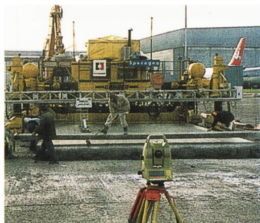
写真—2 センサーレスシステムによる施工状況
