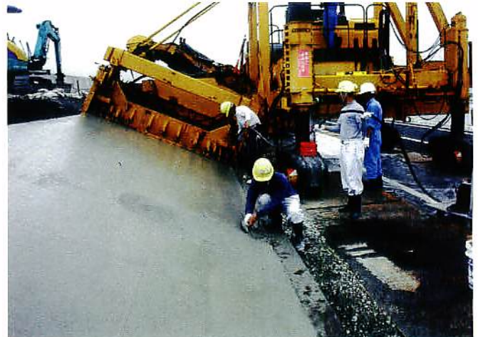
施工状況 スリップフォームペーパーの後ろ側より整形完了後の状況。型枠を設置した法面下は人力で整形している
