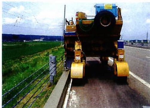
施工状況（後方より）
