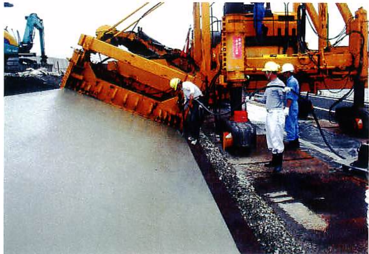
盛土用 平坦部0.75m・法長1.0m 勾配1：1.8 施工中の状況
