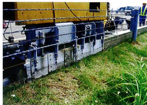
施工状況（路肩側方より）
