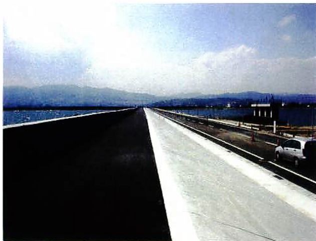
完了 機械施工の上部と下部は人力で施工した
