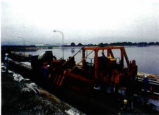
施工状況 アジテータトラックより横取機で材料は供給しスリップフォームペーパーで整形を行っている
