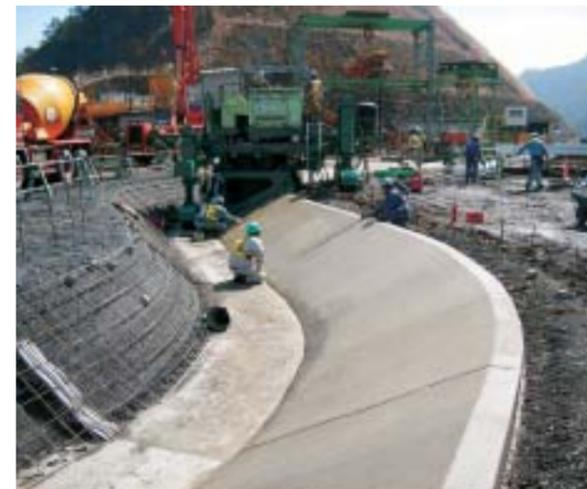
小丸川発電所は揚水発電所であり、上部調整池と下部調整池に分かれている。その上部調整池は周囲2km、幅400m、長さ800m、総貯水容量620万m<sup>3</sup>のとても大きな池である。今回の施工場所は、上部調整池の周囲に設けられる延長2kmの水路のうちの約800mである。形状は幅約4m、深さ約1m、底版幅1mの規模の大型水路である。
