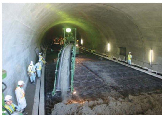
コンクリート打設状況
