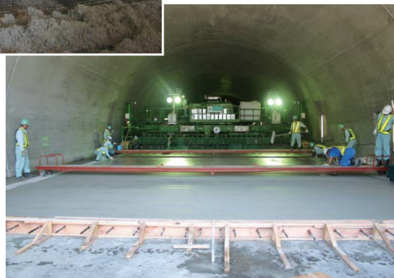
2車線同時施工状況
