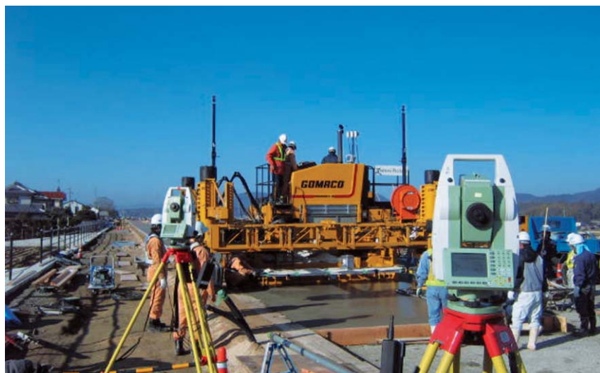
トータルステーションとSF施工機械
