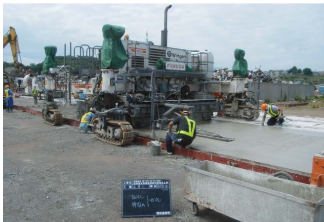
SP950 仕上げ状況
