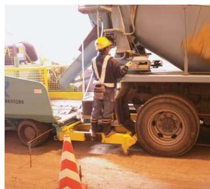
生コン供給状況
