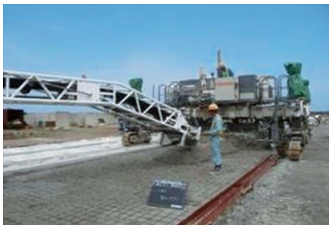
FS150 材料供給状況
