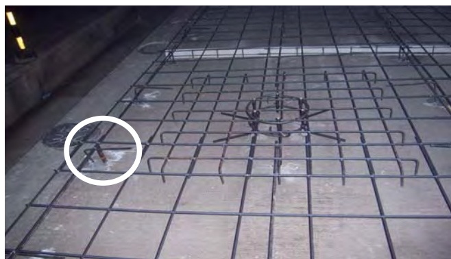
ずれ止め筋の設置状況
