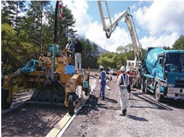
写真2 コンクリート舗装・打設状況 (圧送車による供給)
