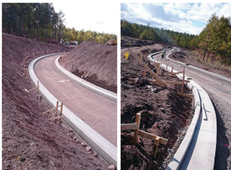
写真1 L型街渠完成
