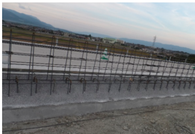
写真－3 躯体配筋状況
