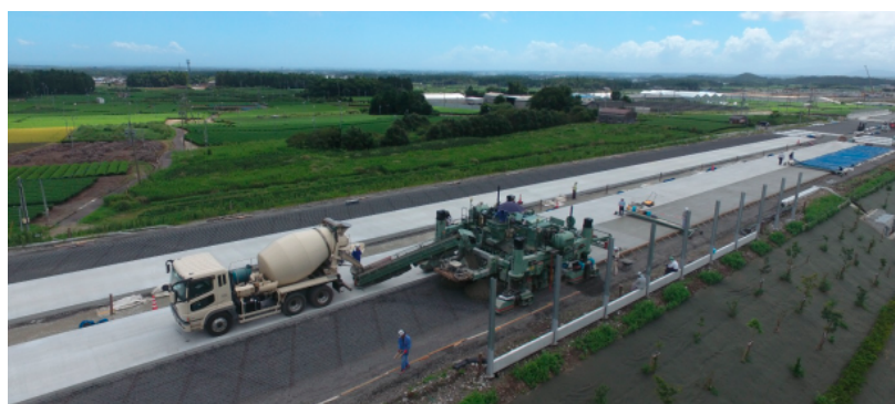
鈴鹿舗装工事での連続鉄筋コンクリート施工状況 (GHP2800)
