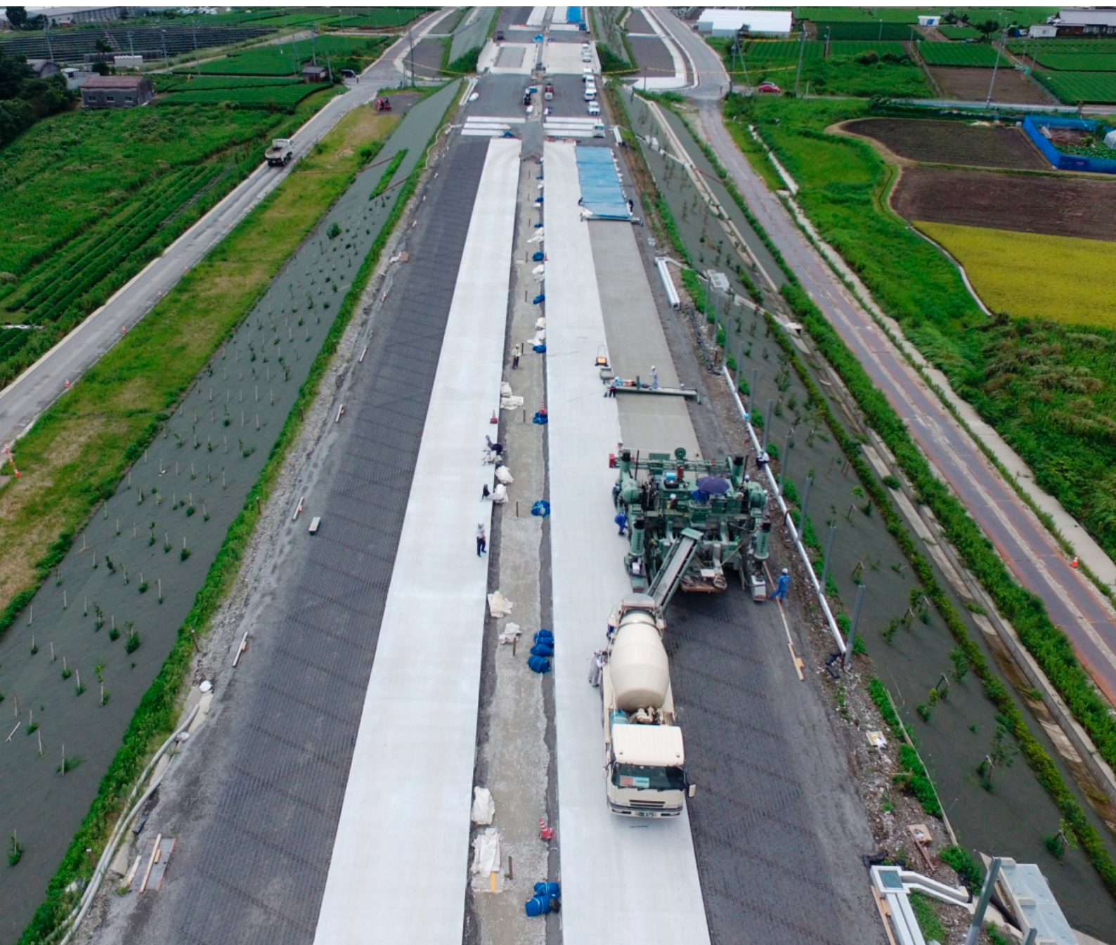
新名神高速道路 鈴鹿舗装工事
