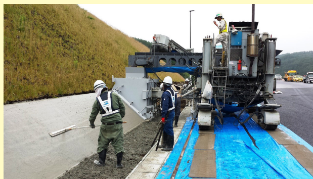
防草コンクリートの施工例
