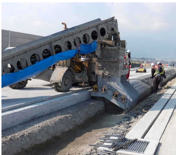
写真－1 基礎コンクリート打設状況
