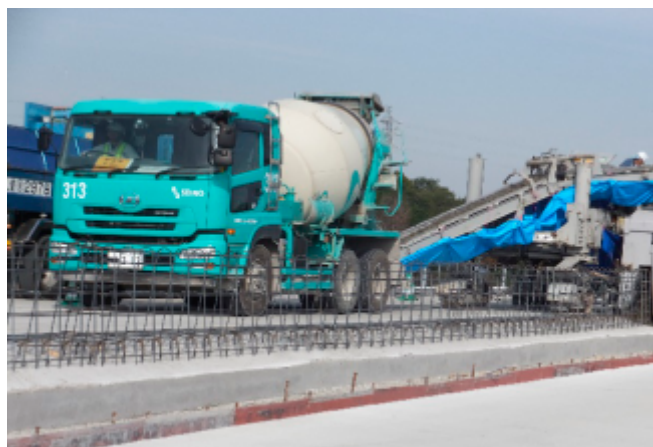
写真－2 躯体コンクリート打設状況
