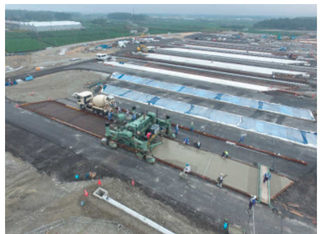
鈴鹿 PA での施工状況
