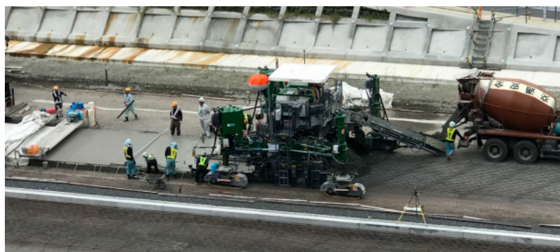
菰野舗装工事での連続鉄筋コンクリート施工状況 (SP64i)
