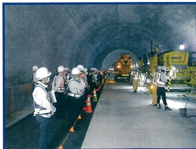
写真－５ 施工現場見学会状況－２
