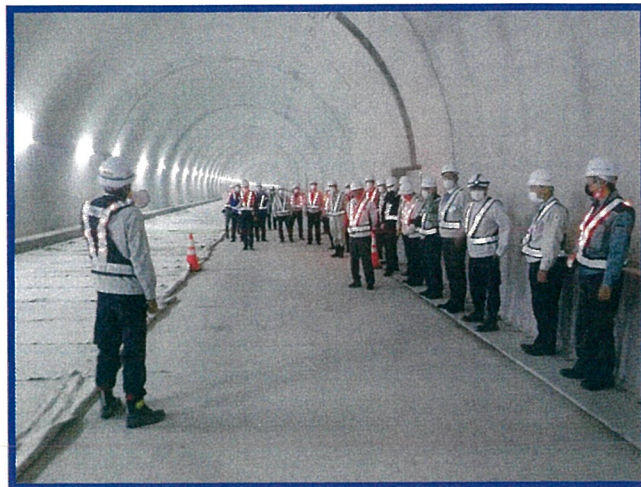
写真－４ 施工現場見学会状況－１
