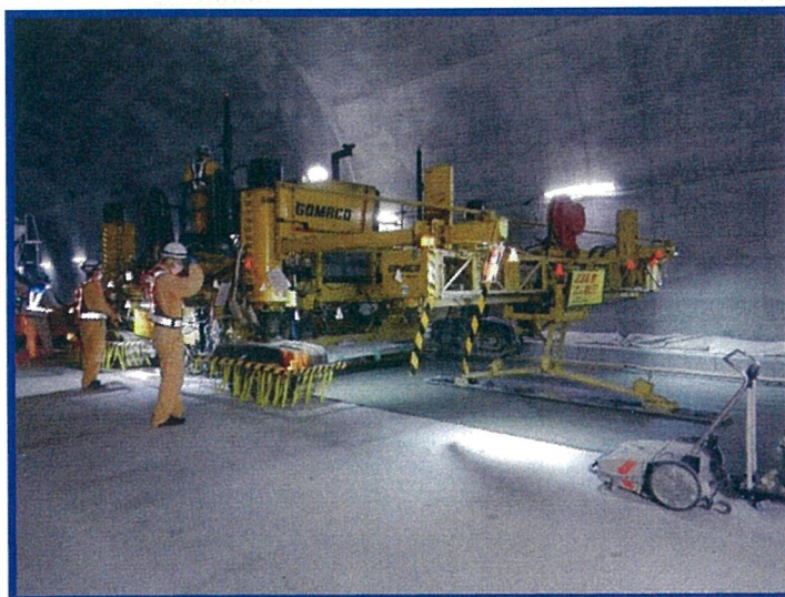
写真－２ TS を用いた ICT 施工状況
