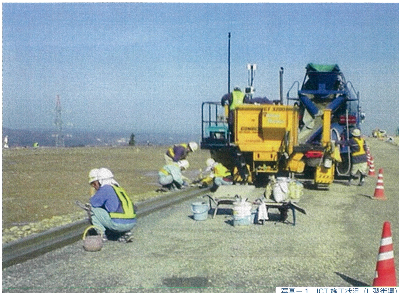
写真－１ ICT 施工状況（L 型街渠）
