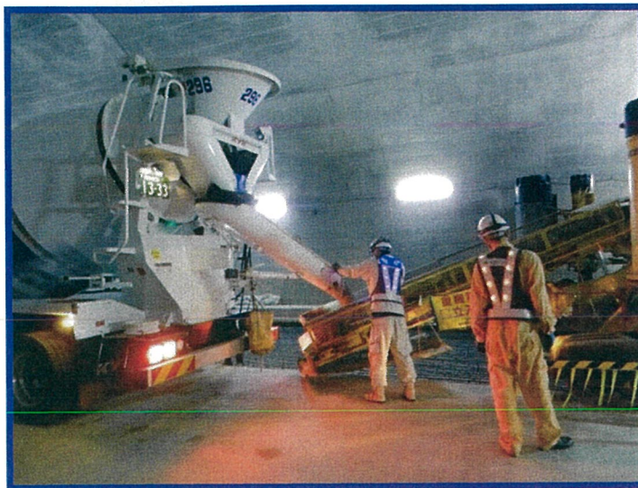
写真－１ スリップフォームペーバへの荷下ろし状況
